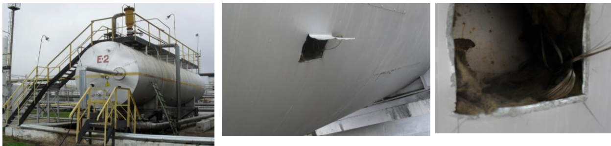
Рисунок 1.10 – Теплоизоляция емкости E_2
